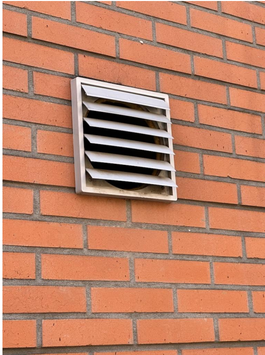
Ventilatieopening. Foto: Michiel Huijsman
